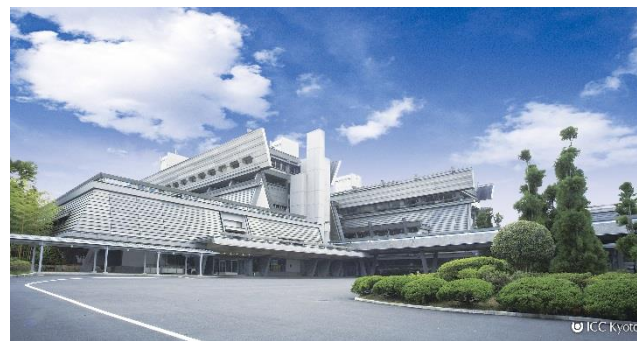
国際会館正面玄関
